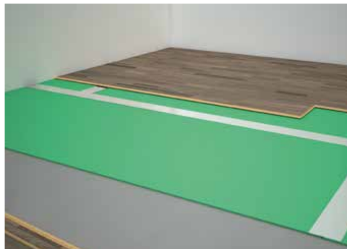
Installatie MAGNUM Isofoam
